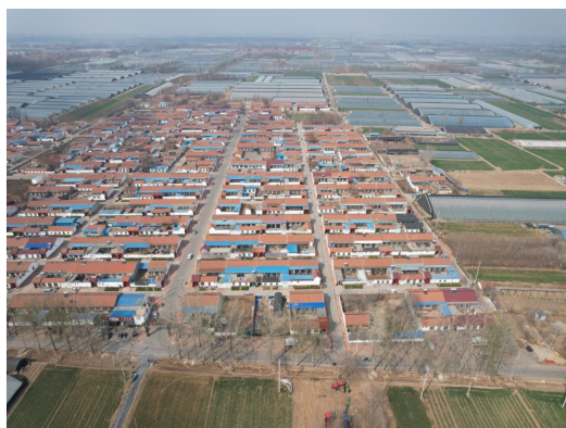
调查地块北侧相邻地块-东高湛东村村民住宅
